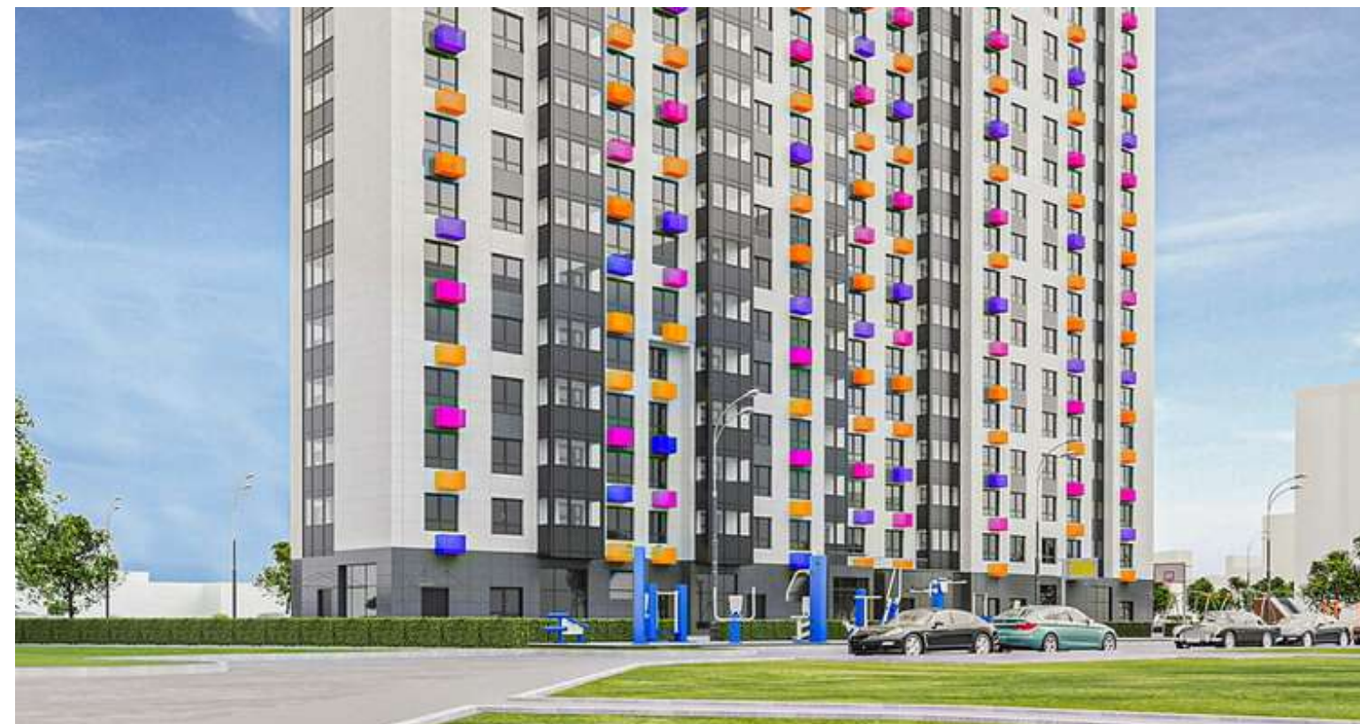
Департамент строительства г. Москвы, Дом по программе Реновации- г. Москва, ул. Молодцова 25/1 Арматура более 2000 тонн. 2020г.- 2021г.
