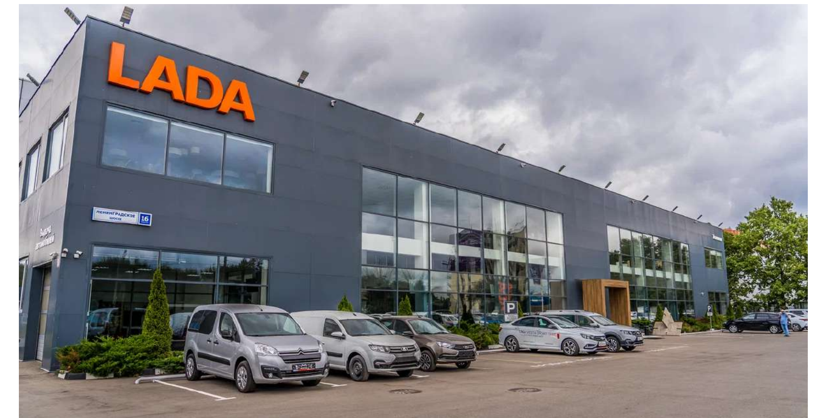
Автосалон LADA г. Химки, Ленинградское шоссе вл.16. Производство и монтаж металлоконструкций, общий объем 750т.
