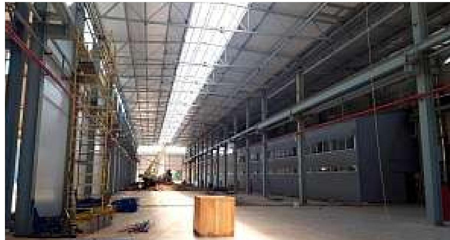
Строительство нового цеха завода крупнейшего производителя алюминиевого профиля в Российской Федерации «Алвид», 2021
