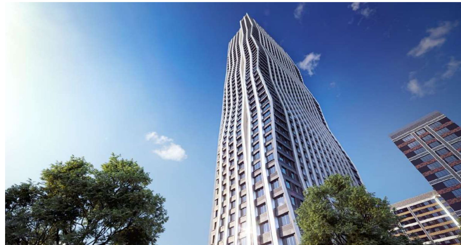
Afi tower Поставка арматуры. 3300т. арматуры 2020г.- по н.в.
